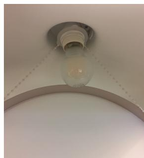
Monter en lyskilde. Diffuser enheden har monteret 2 sikkerhedssnore. The diffuser is fasten with two security strings.
