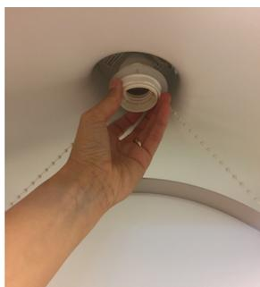
Monter metaldiffuseren med plastikringen på fatningen. Mount the metal diffuser by the plastic ring, onto the socket.
